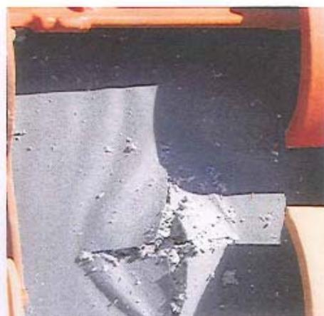
► Sous les rampants, avant injection de la ouate, on perce le pare-pluie. L'injection commence en bas de pente. Une pastille d'étanchéité à la pluie vient reboucher le pare-pluie. Forte densité en injection: 60 kg/m<sup>2</sup>.
